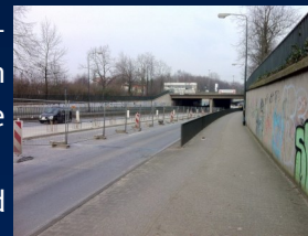
Problematik behindertengerechte Ausgestaltung S-Bahnhof Eller - Treppenliftidee
